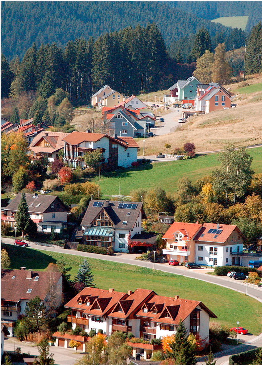
Neustadt klettert den Hang hinauf. An der Fehrn sind schon viele der bisher erschlossenen Bauplätze vergeben.
